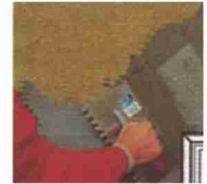
Köşelerin extra file ile güçlendirilmesi
