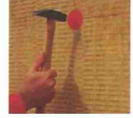
Dübelerin yerine çekiçle yerleştirilmesi
