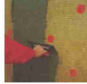
Malanın düz tarafı ile sıva harcının düzeltilmesi
