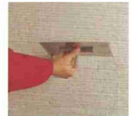
Dekoratif kaplamalar mala yardımıyla yüzeye uygulanır. Uygulanacak kalınlık, sıva tiplerine göre değişmektedir.
