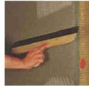
Rockmanto donatı filesinin montajı
