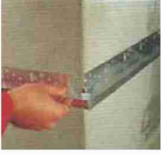
Profil yüksekliğinin ölçülüp yerleştirilmesi
