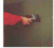
Sıvanın malanın dişli tarafı ile sürülmesi
