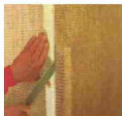
Köşedeki yalıtım fazlasının kesilmesi
