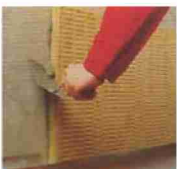
Fazla yapıştırıcının temizlenmesi
