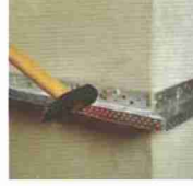
Profilin montajı ve vidalanması
