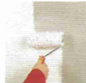
Akrilik esaslı son kat kaplama malzemesi kullanılarak yüzeyler öncelikle astarlanmalı mineral esaslı kaplama malzemesi tercih edilir ise astar, kaplama uygulamasının ardından yüzeye uygulanmalıdır.
