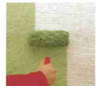
Mineral esaslı kaplama üzeri boya uygulaması
