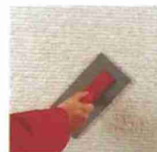
Kaplamlar henüz kurumadan, plastik bir mala ile yüzeyinde perdelanarak tekstür oluşturulur. Mineral esaslı olduğundan, kuruduktan sonra mutlaka su bazlı Dış Cephe Boyaları ile boyanmalıdır.
