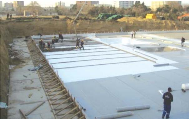
Multiplan BA her türlü yapının temel bohçalama ve üstü kapanan su yalıtımı detaylarında kullanılabilen, UV dayanımsız, donatısız, sıcak hava kaynağı ile birleştirilen, yumuşak PVC su yalıtım membranıdır.
