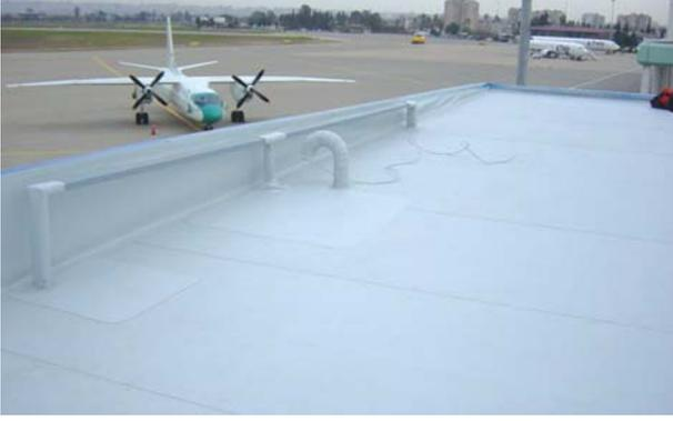
Atmosfer koşullarına ve güneş ışınlarına dayanıklı, polyester donatılı, sıcak hava kaynağı ile birleştirilen, yumuşak PVC su yalıtım membranıdır. Multiplan FG serisi PVC su yalıtım membranları, özellikle zorlu hava şartlarına ve güneş ışınlarına maruz kalan tüm çatılarda kullanılmak üzere geliştirilmiştir.
